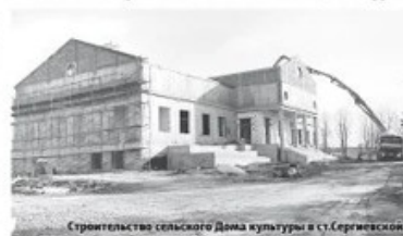
Строительство сельского Дома культуры в ст. Сергиевской
